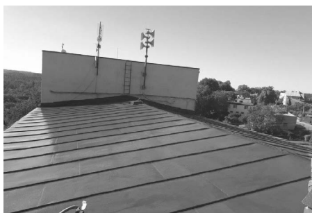
Nový nátěr střechy KD
