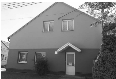
Opravená fasáda tělocvičny
