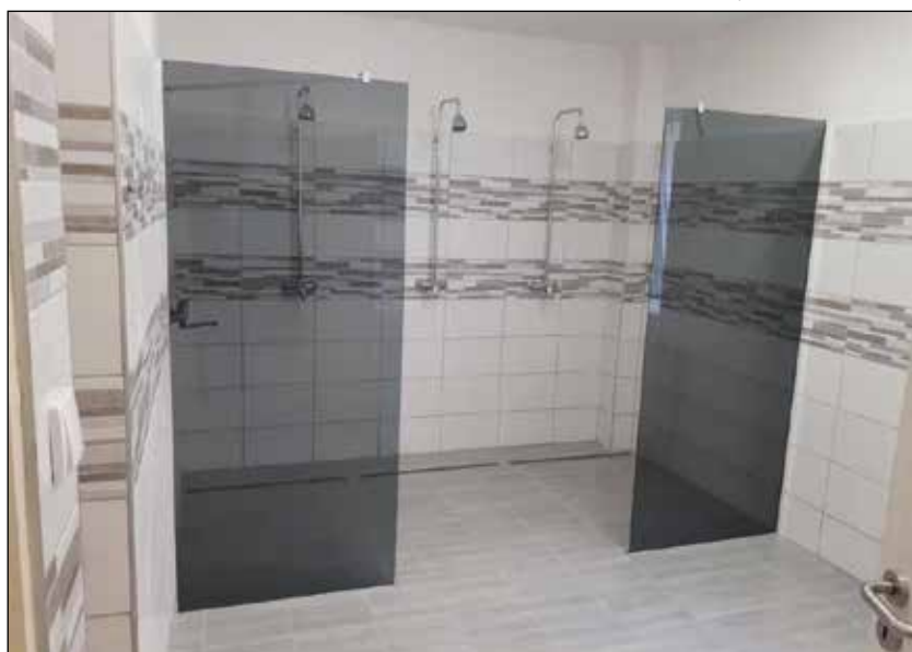
Nové sociální zařízení v tělocvičně
