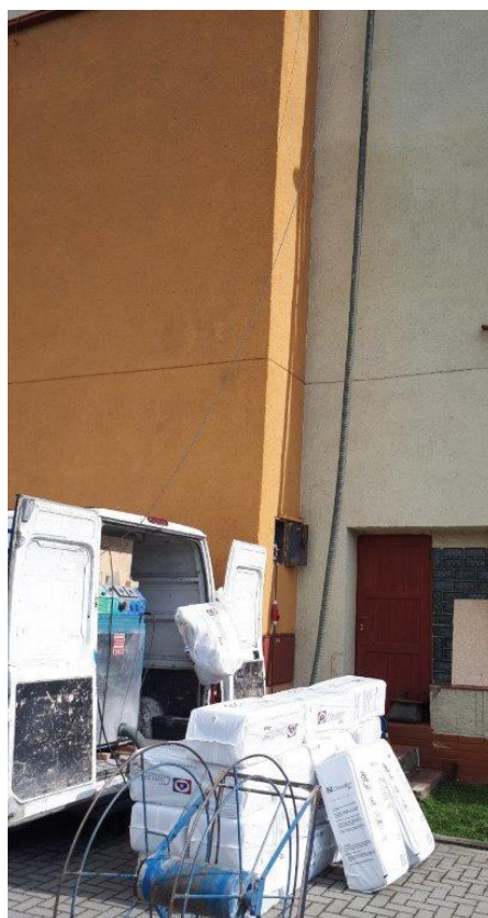
Zateplení střechy kulturního domu
