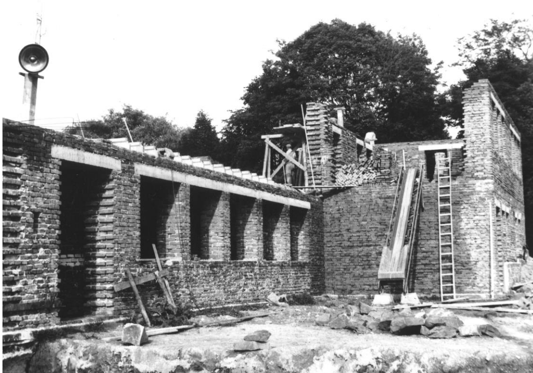
Pohled na rozestavěnou restauraci v KD
