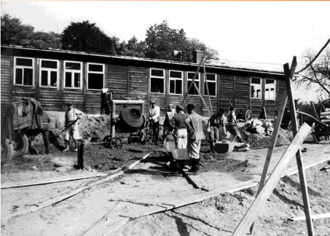
Práce na stavbě kulturního domu
