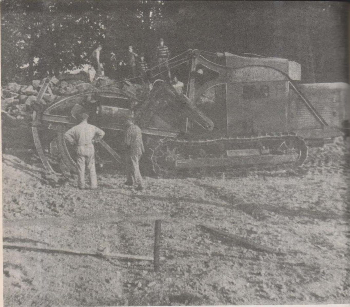
2. října 1959 vyhloubil rýhovač za 4 hodiny rýhy pro hlavní základy
